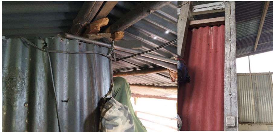
Gambar 2. Dokumentasi hasil pemeriksaan instalasi rumah.
